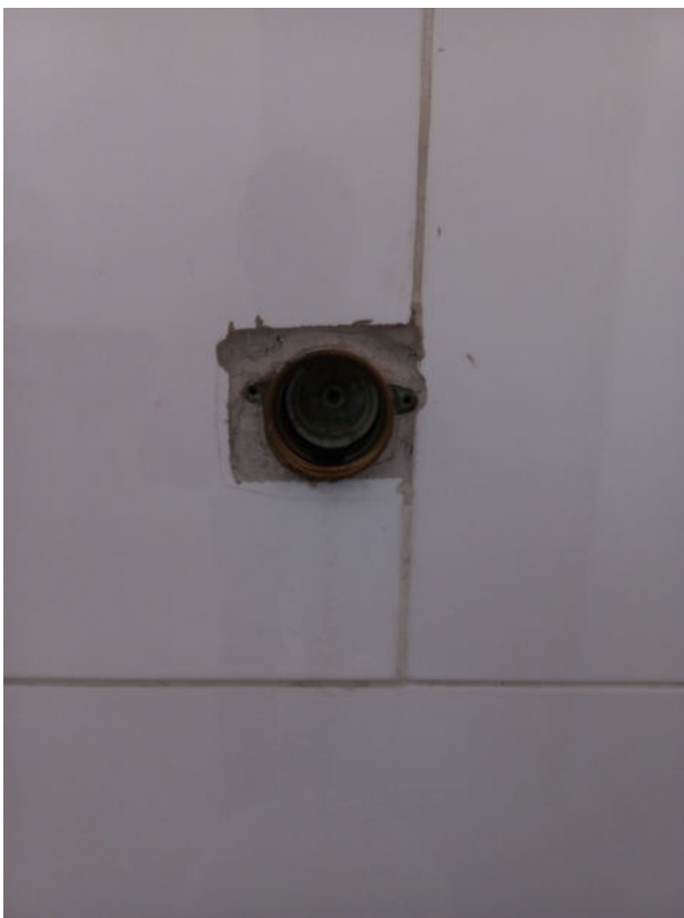
14/12 – substituição reparo de válvula com defeito banheiro masculino recepção.
