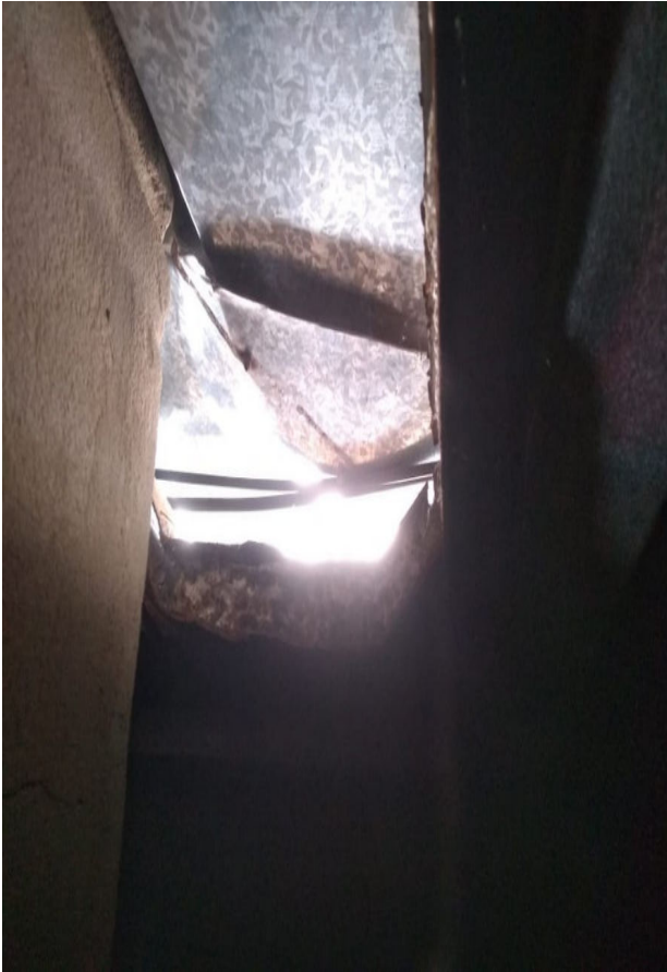
19/12 – manutenção do telhado (rufo solto) fixação do rufo com parafuso brocante e proteção com PU
