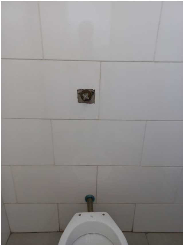
14/12 – substituição 2º reparo de válvula com defeito banheiro masculino recepção .
