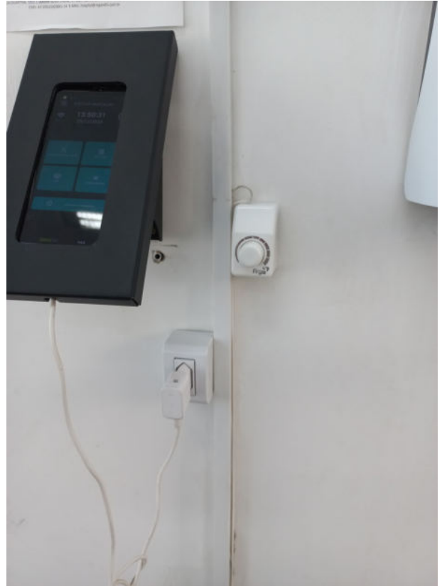
29/12 – substituição de dimmer de ventilador com defeito recepção
