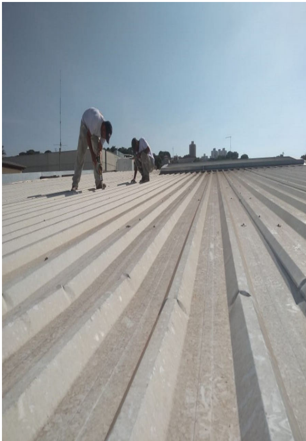
19/12 – manutenção do telhado (rufo solto) fixação do rufo com parafuso brocante e proteção com PU
