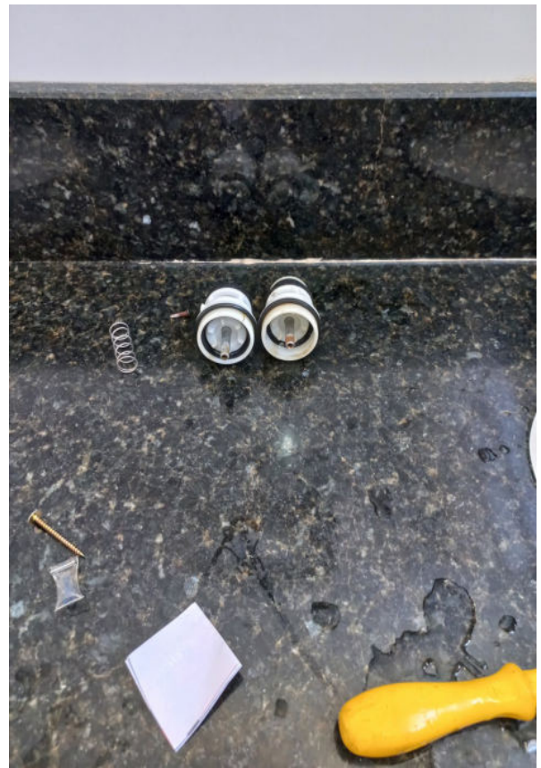
14/12 – substituição 2º reparo de válvula com defeito banheiro masculino recepção .
