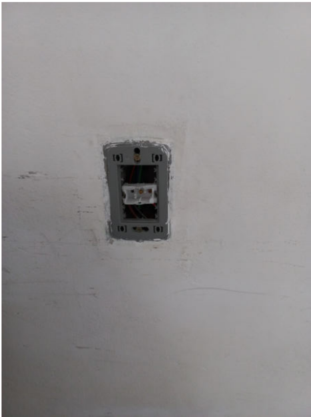
13/12 – substituição interruptor de lampada danificada observação pediatria
