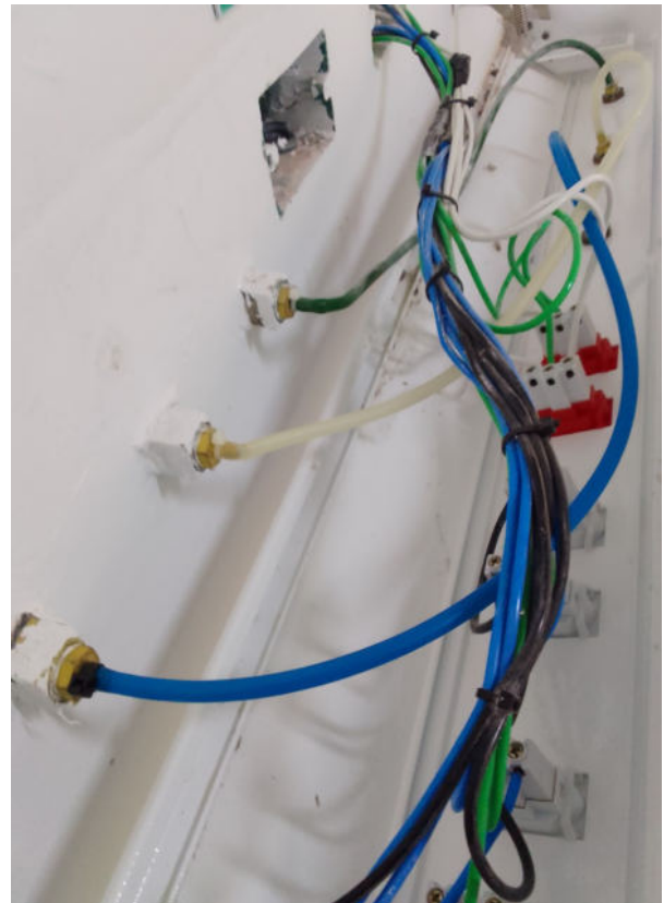
06/12 – substituição de mangueira ressecada do ar comprimido leito 6
