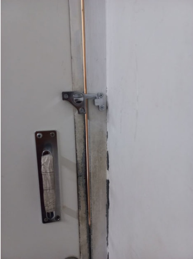
22/12 – instalação de trinco porta raio X
