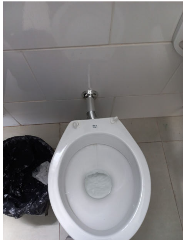
13/12 – substituição do conjunto de ligação ajustável vestiário feminino
