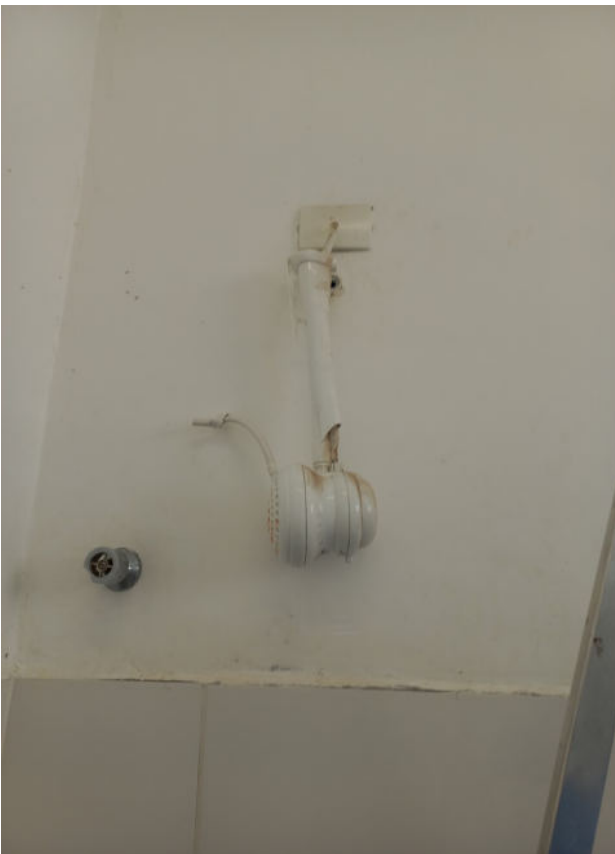
18/12 – substituição mangueira de ar comprimido ressecada leito 3.
